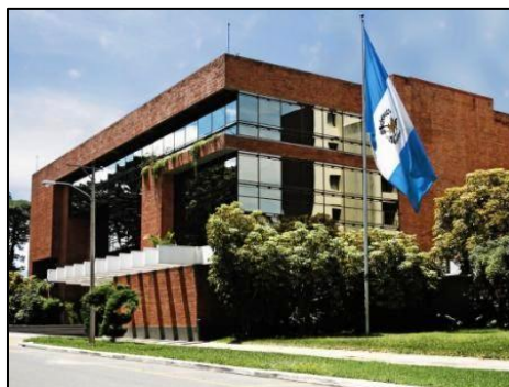
Figura No. 1: Edificio ANACAFÉ, zona 14. (ANACAFÉ, 2012)
