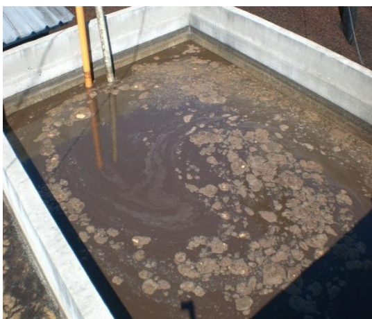
Imagen No. 17: Aguas miel de beneficiado
